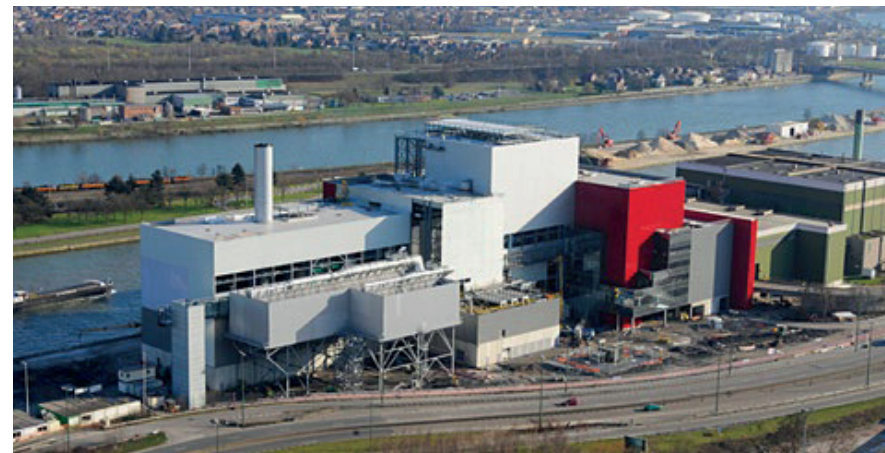
Centre de valorisation énergétique UVELIA - INTRADEL
